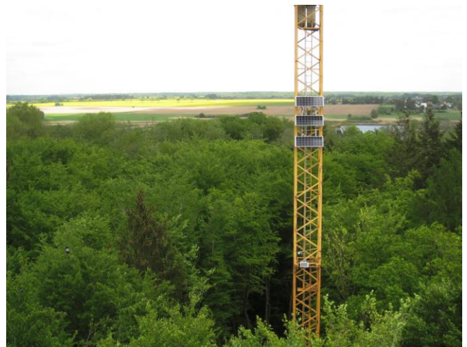
© FeMoPhys: Luftbildaufnahme des im Wald installierten 45 m hohen Drehkrans am Forschungsstandort des GFZ bei Demmin
